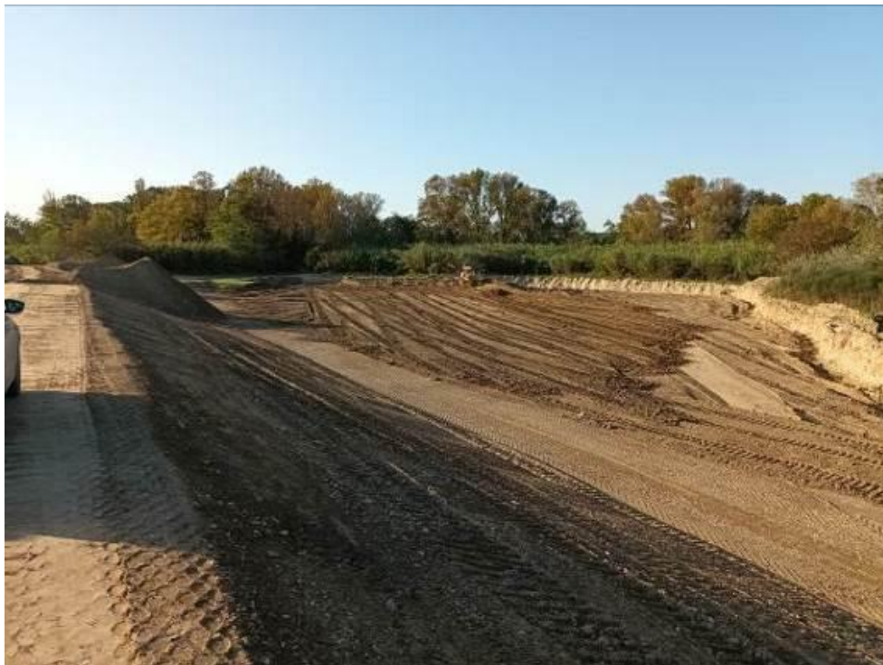
Vue depuis la digue en élévation vers l'aval et zone de prélèvement de matériaux
