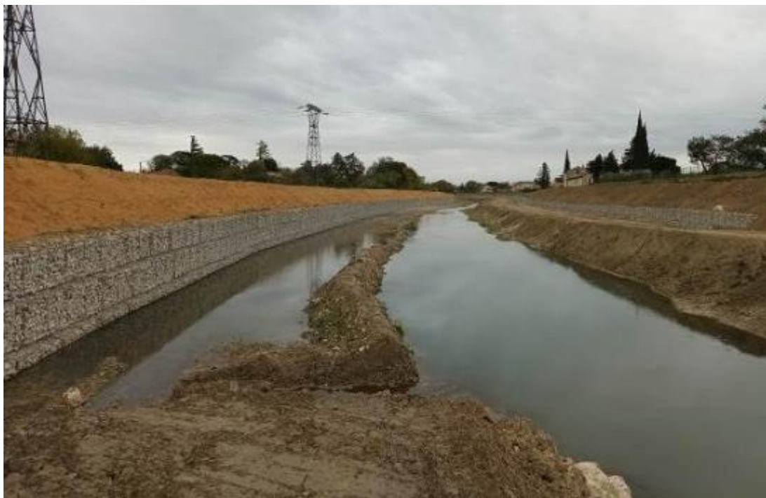
Photo prise depuis l'aval de la zone de travaux vers l'amont
