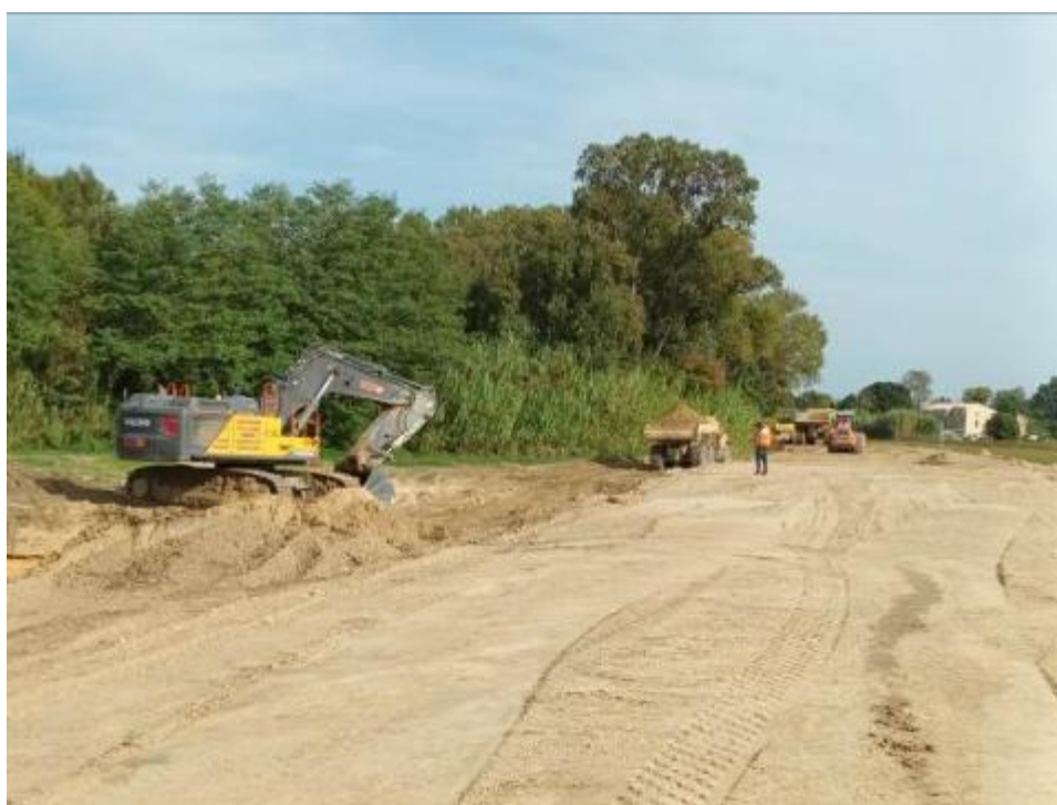
Terrassement et élévation digue de contention des Ramières
