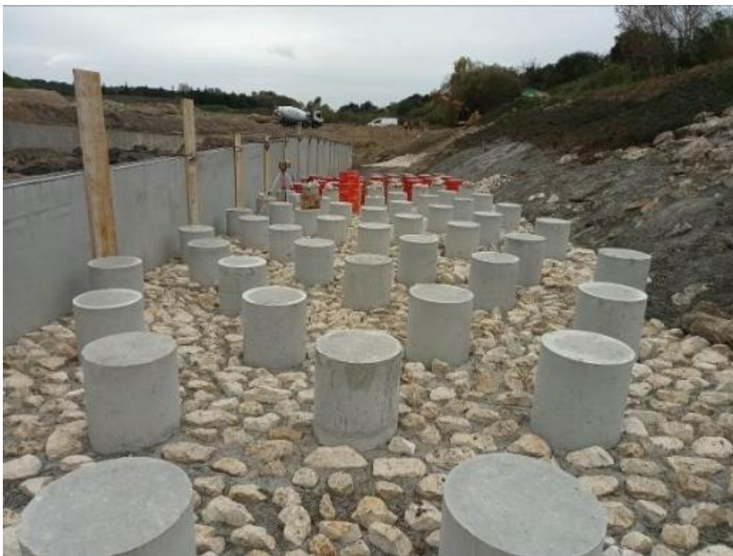
Vue depuis l'amont de la passe à poissons
