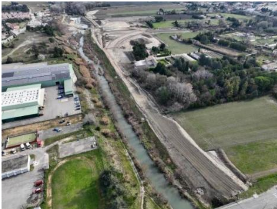
Vue aérienne emprise digue de la Reine (pont des Pompiers au premier plan)
