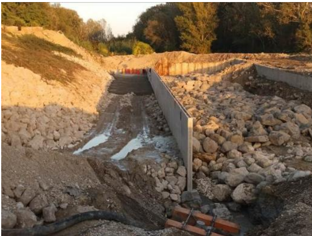
Phase de terrassement de la passe à poissons (partie gauche de la photo) et du seuil des Jardins (partie droite)
