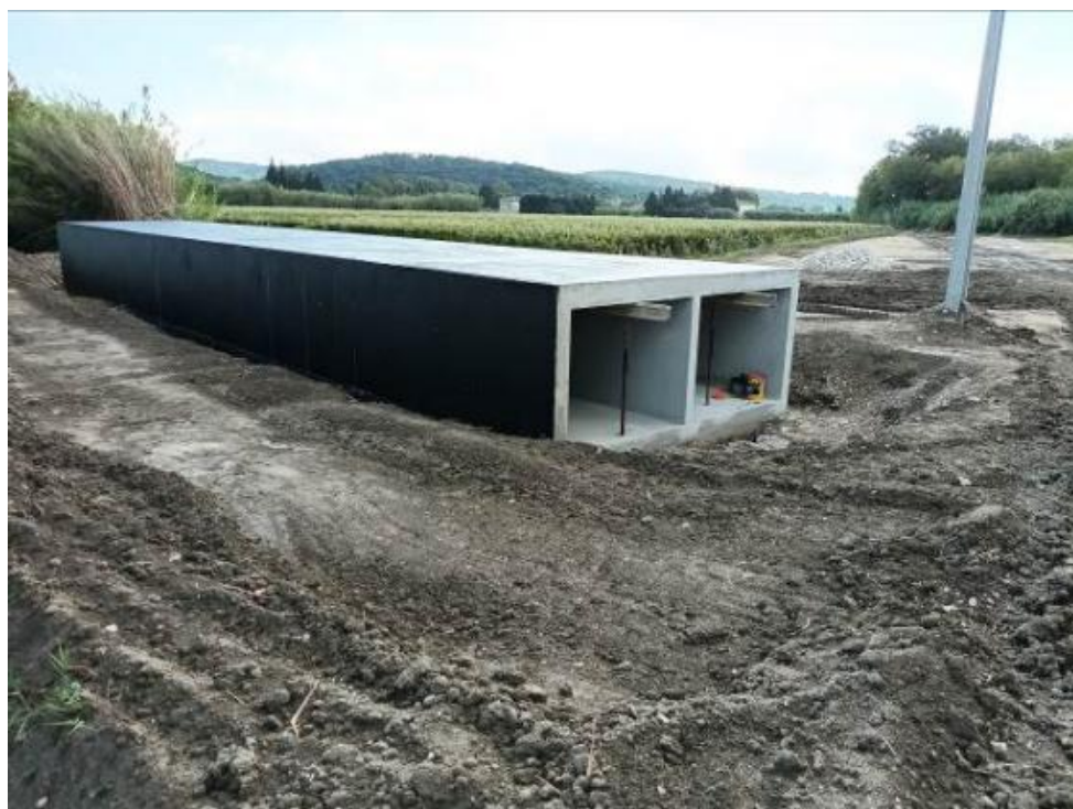
Ouvrage de transparence hydraulique de la Combe Gaillarde achevé
