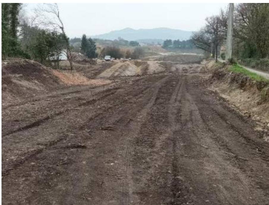
Vue de l'emprise global digue de la Reine et canal de décharge depuis le Sud
