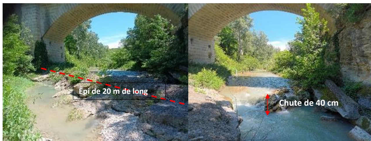
Vue de l'aval vers l'amont en se plaçant coté rive droite (photo de gauche) et en se positionnant coté rive gauche (photo de droite)
