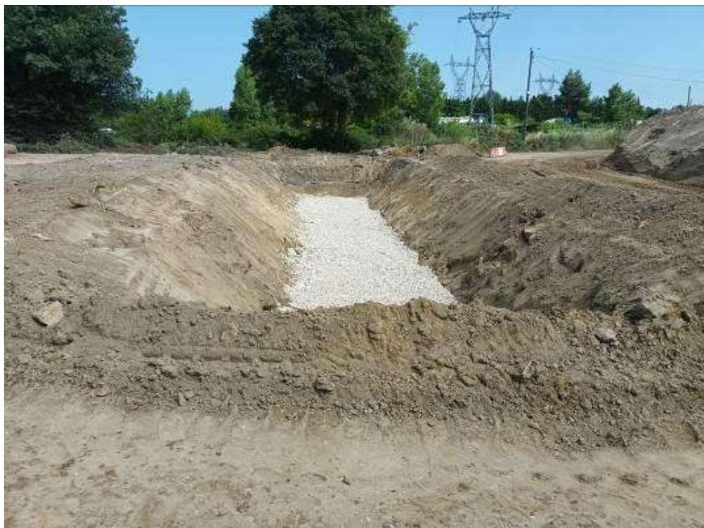
*Photo prise depuis l'aval en direction du Nord – Terrassement de l'emprise de l'ouvrage hydraulique sous la digue et sous la voirie « Ancienne route de Mondragon »*
