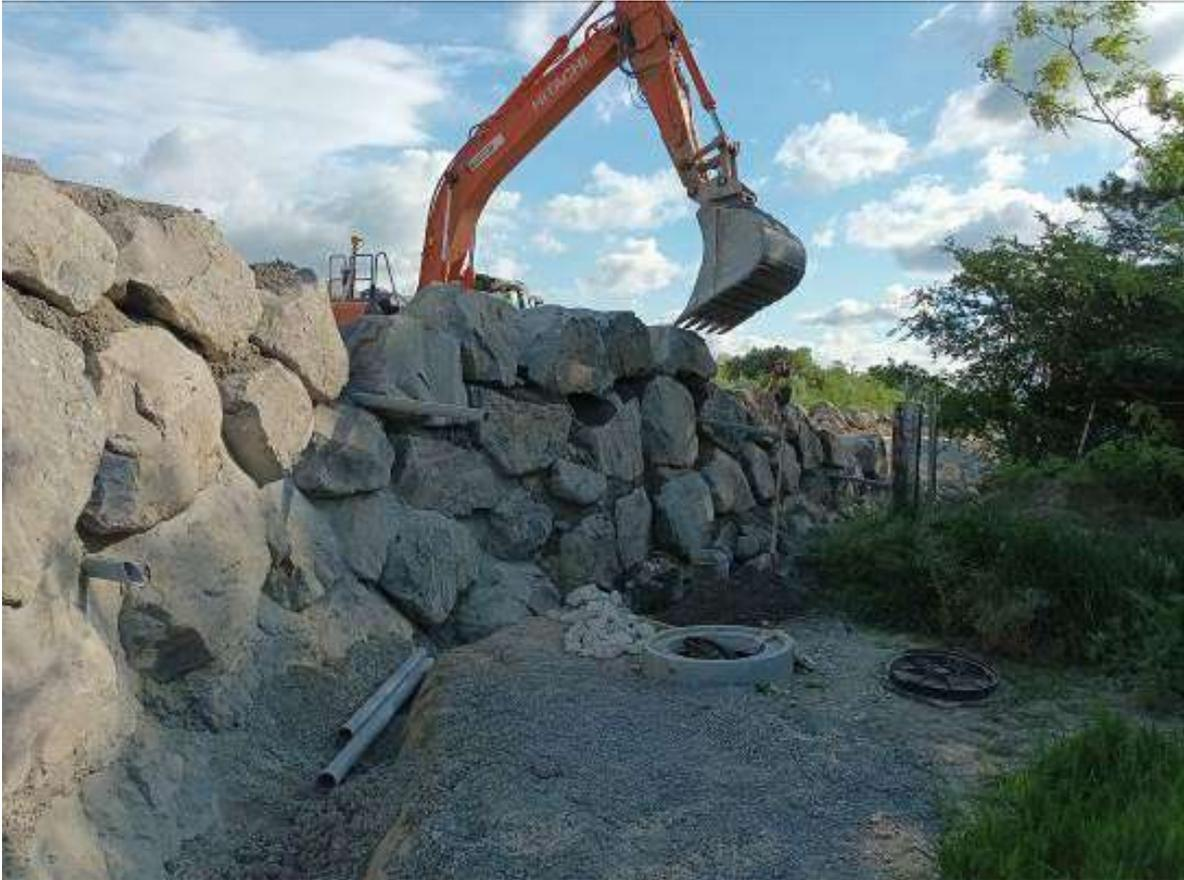
*Photo phase de construction mur en enrochements – Digue de la Reine*
