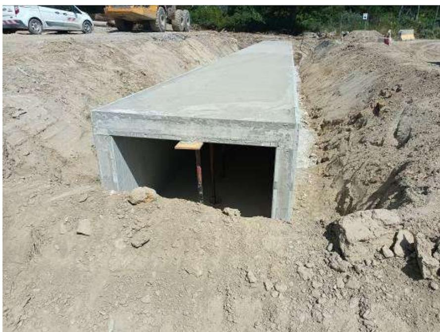
Ouvrage hydraulique réalisé par coulage béton sur la base de pré-murs
